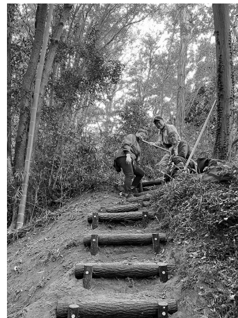
遊歩道・階段の整備(日野市)
